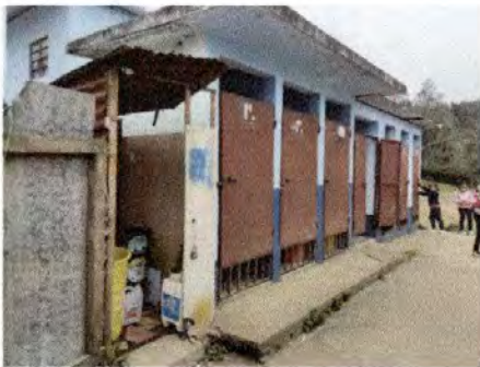
Foto 3: Sustrucción de puertas servicios sanitarios
