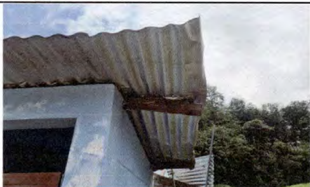
Foto1: Sustrucción de soporte de madera a metal
