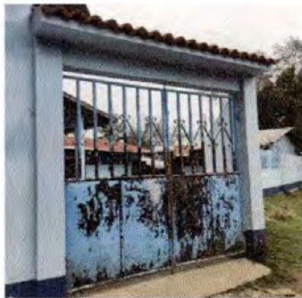
Foto 1: Sustrucción de portón de metal
