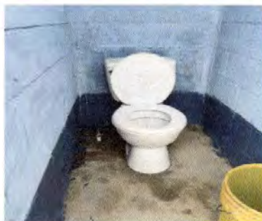
Foto 5: Sustrucción de inodoros
