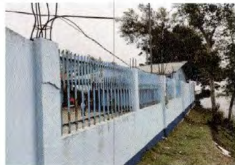
Foto 6: Mantenimiento de baranda de metal
