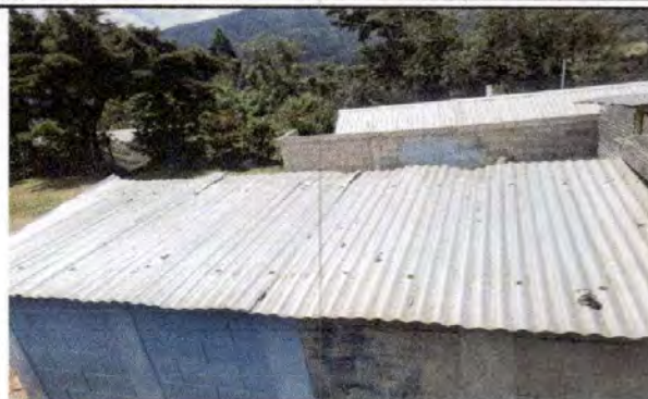
Foto 2: Sustrucción de lamina troquelada
